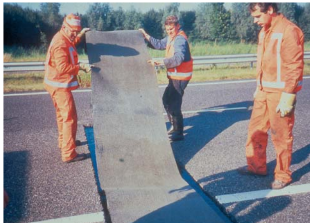
Voorbeeld 2 SAMI aanbrengen
