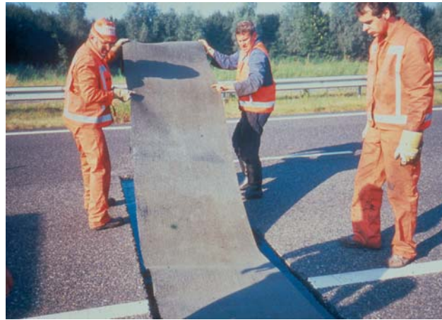
Voorbeeld 2 SAMI aanbrengen
