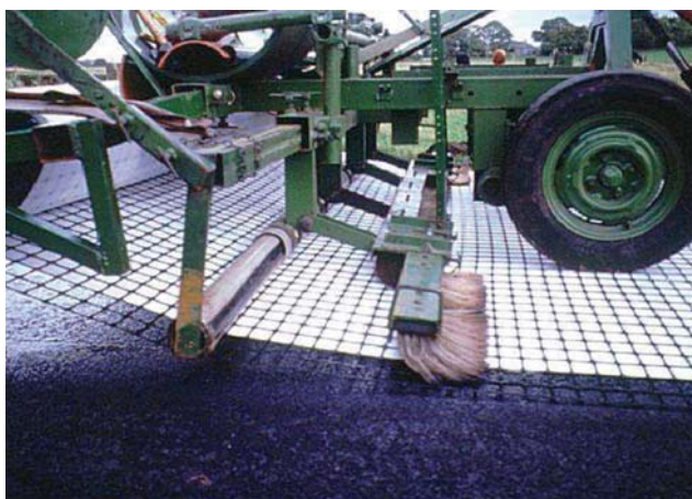
Voorbeeld 3 Gecombineerd wapeningsmateriaal aanbrengen
