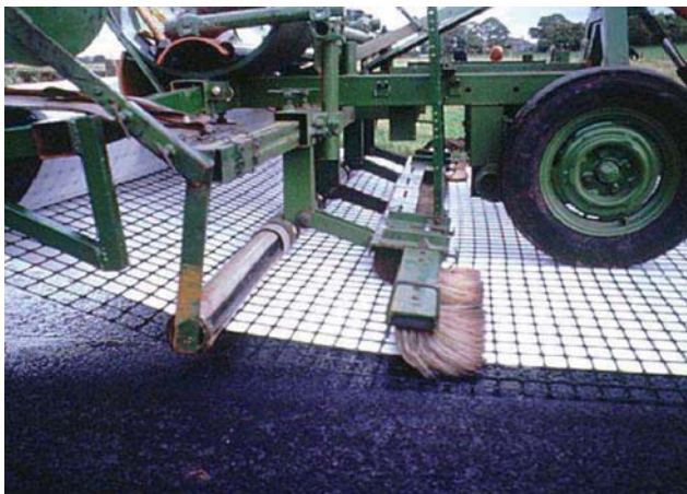
Voorbeeld 3 Gecombineerd wapeningsmateriaal aanbrengen
