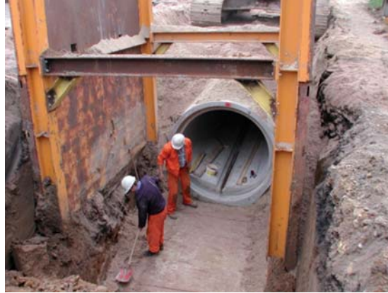
Voorbeeld 2 Sleufbekisting plaatsen
