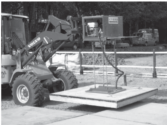
Voorbeeld 3 Betonplaat leggen
