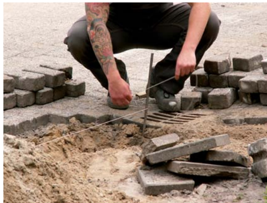
Voorbeeld 4 Kantopsluiting uitzetten en plaatsen
